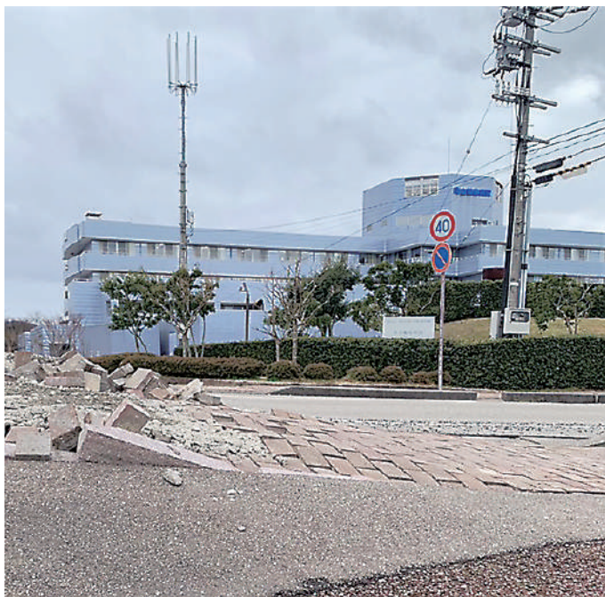
市立輪島病院と被災した道路
